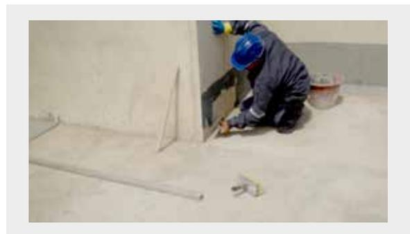
4. Após a secagem dos cantos, usando uma desempenadeira lisa de 30 ou 40 cm, aplicar as demãos de bsPOWER, com espessura média de 1 mm;
