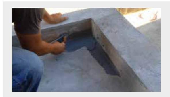
Para o encontro entre o piso e a parede, não é necessária a confecção de meia cana, deve-se deixar os cantos com  $90^\circ$ , porém RECOMENDAMOS o uso de tela de POLIÉSTER na aplicação da segunda demão até uma altura média de 20 cm, ou seja, 20 cm na parede e 20 cm no piso. Devem-se aplicar nos cantos as mesmas quantidades de demãos recomendada para o sistema.
