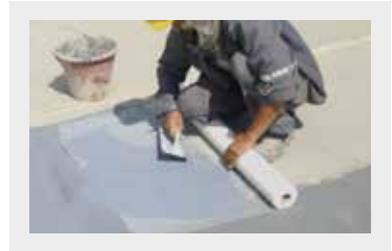
5. Após a aplicação da demão com a tela, aplicar a terceira demão e as demais, se houver, sempre respeitando o intervalo mínimo de 24 horas, conforme figura do item 3.2.;
